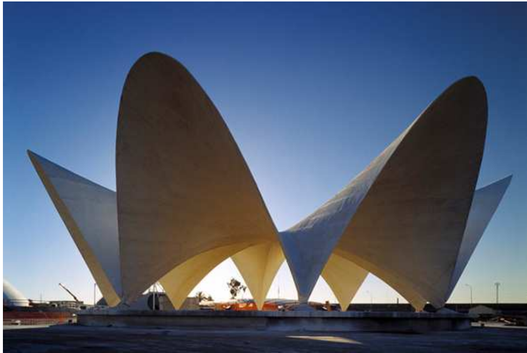
Betonové konstrukce B03C + B03K
