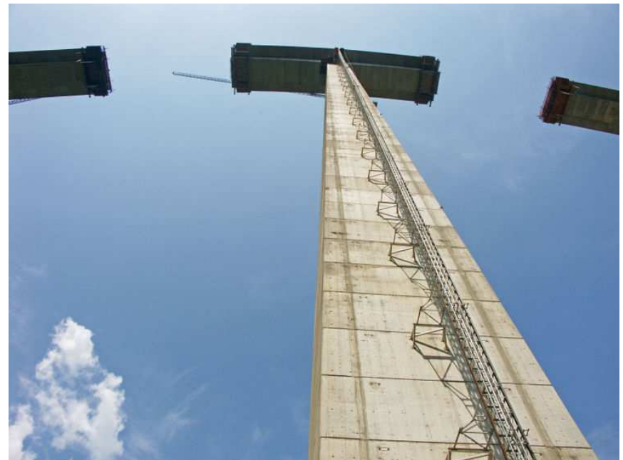
Betonové konstrukce B03C + B03K
