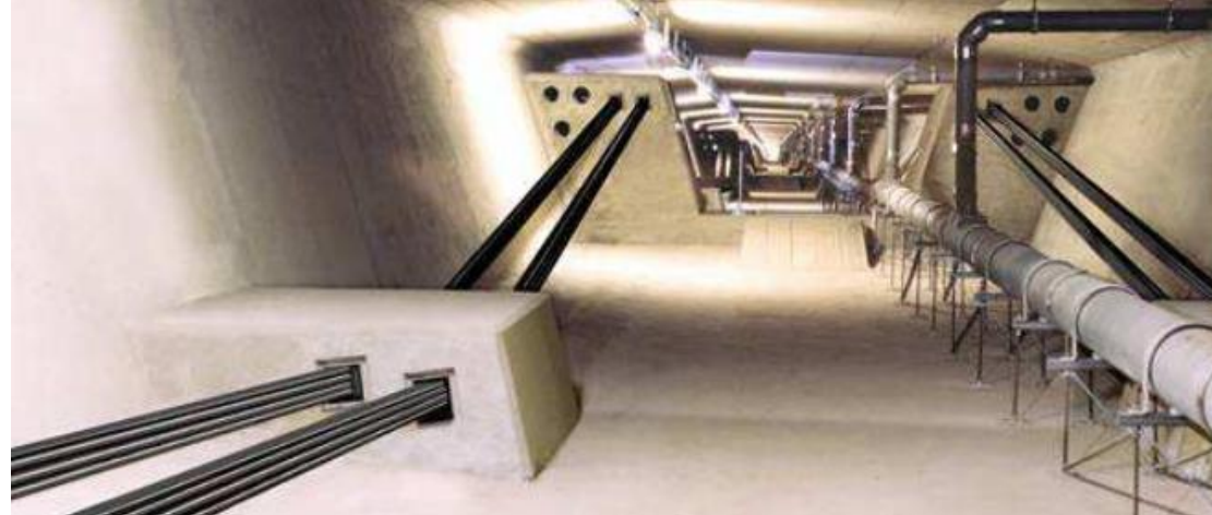
Deviátory komorového nosníku [1]
