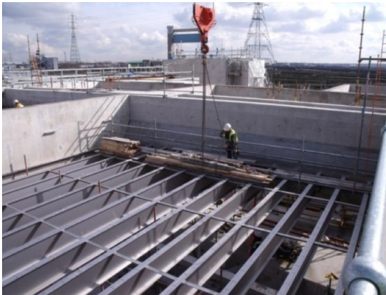
Úpravna vody (UK)
