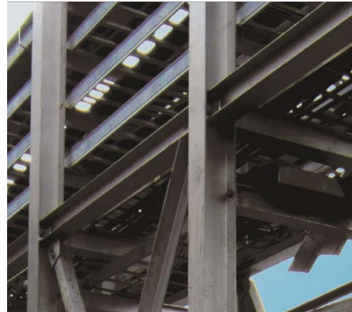
Konstrukce jaderné elektrárny
