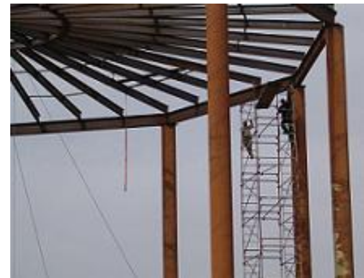
Kónická střecha nádrže podpíraná sloupy - montáž
