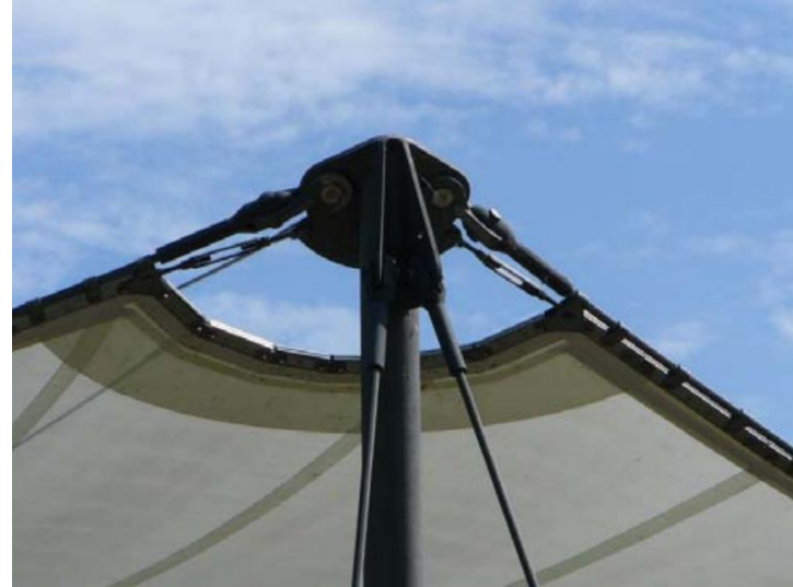
Kotvení do sloupu
