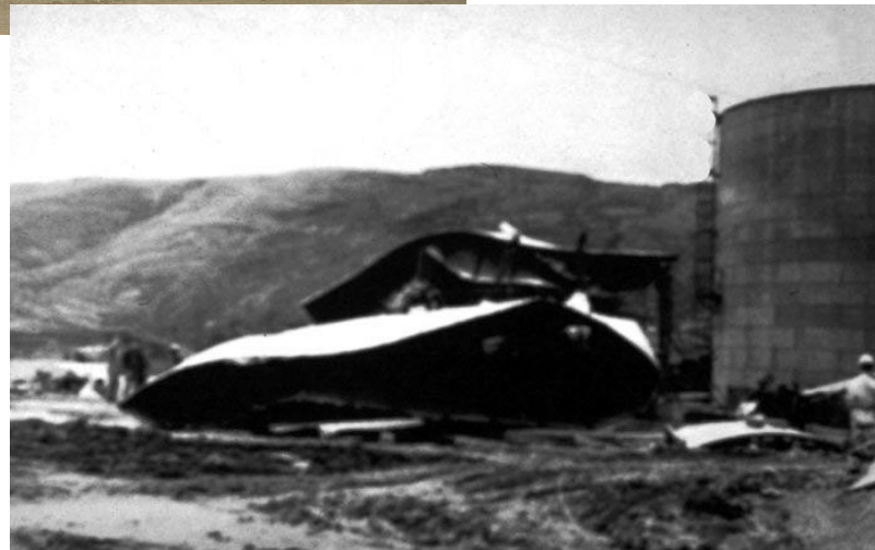
Oddělení nádrže od základu, porucha způsobená větrem
