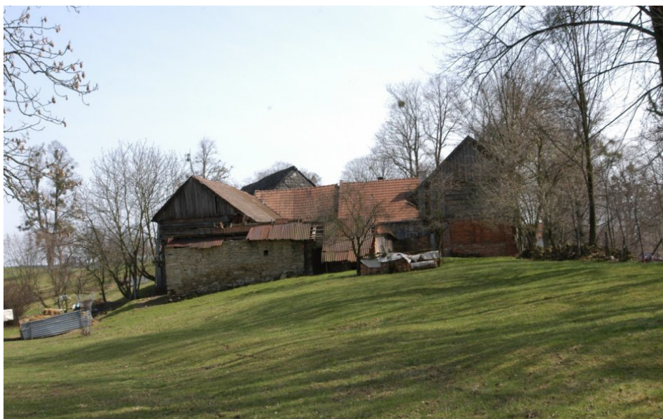
Obr. 1 Pohled z příjezdové cesty
