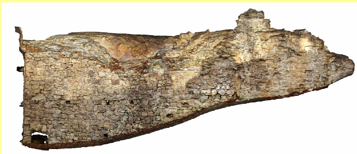
Obr. 3: Pohled na východní zed'
