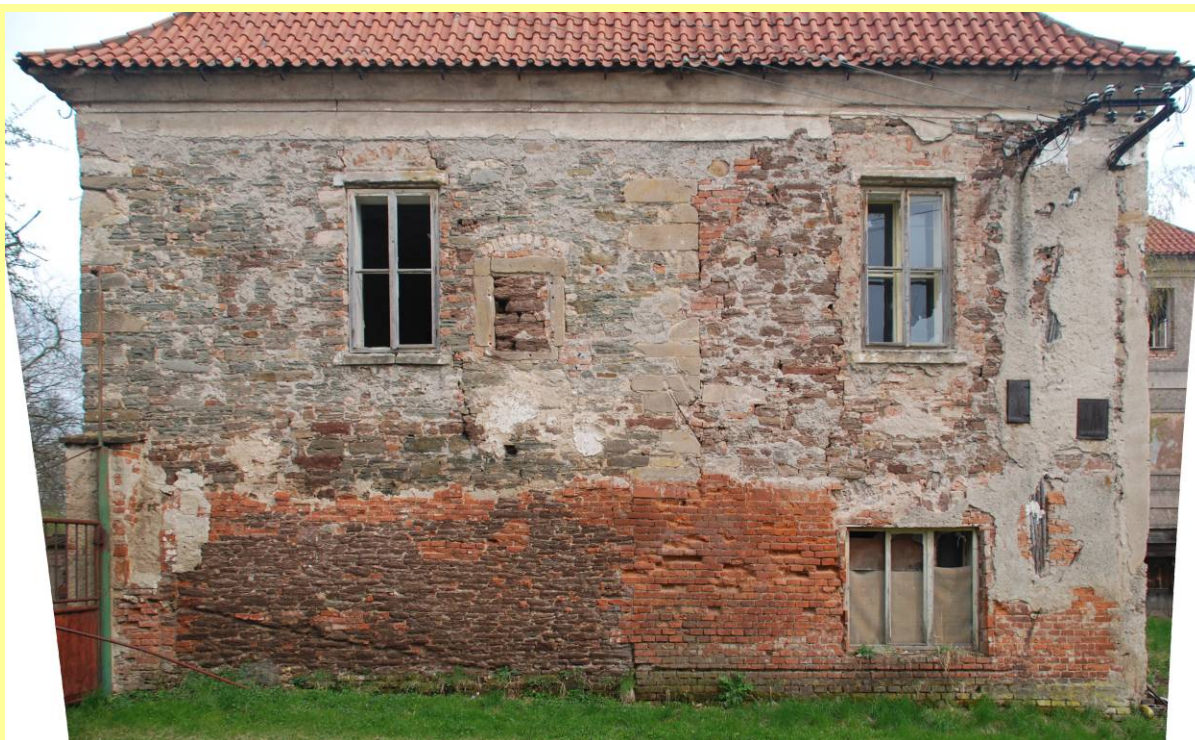
Obrázek 4: fotoplán západního průčelí severního křídla
