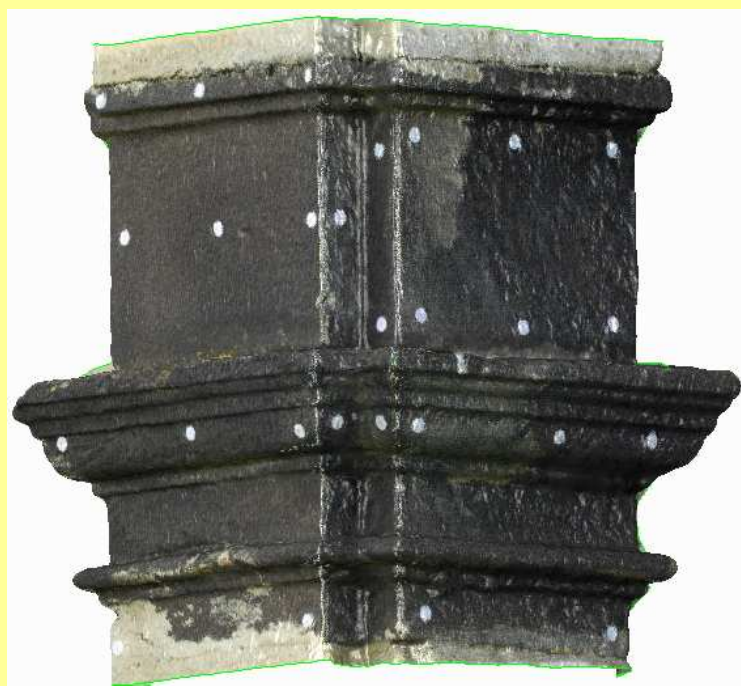
Obr. 3: 3D model pilastru zastavení 24 (Geomagic Studio)
