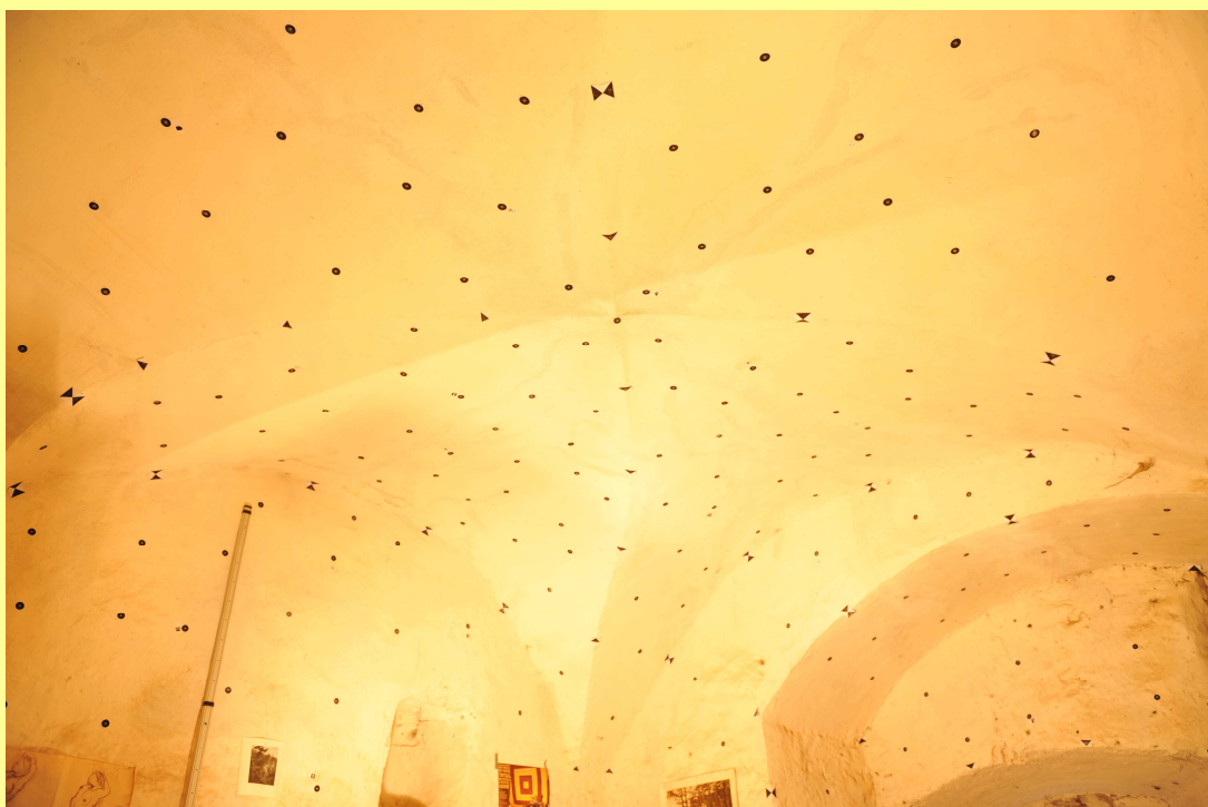
Ukázka signalizace vyhodnocované stropní klenby
