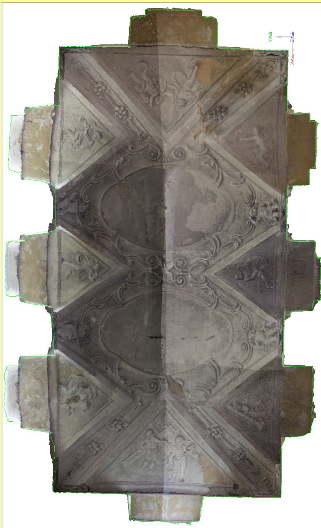
Obr.: Prostorový model klenby pokrytý texturou ze snímků
