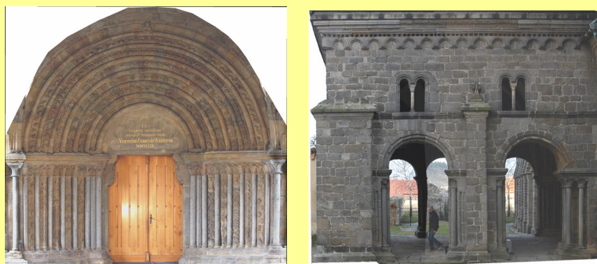
Ortofoto portálu a západní stěny předsíně
