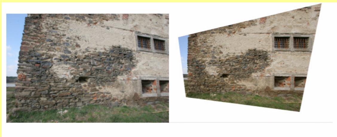
Ukázka tvorby fotoplánů stěny věže (na prvním obrázku je snímek stěny pořízený v terénu a na druhém obrázku je snímek již transformovaný na vlíčovací body na stěně)
