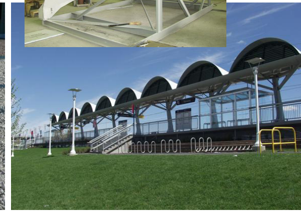
Shawnessy Station, Calgary, Alberta, Kanada. Tloušťka skořepiny 20 mm, rozpon 6 m
