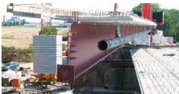
Obrázek 45: Prefabrikovaný ocelobetonový nosník, varianta E2
