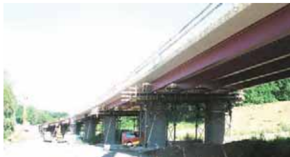
Obrázek 45: Prefabrikovaný ocelobetonový nosník, varianta E2
