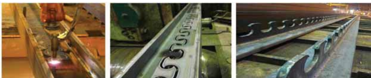
Obrázek 36: Návrh a výroba spřažení Precobeam v dokončovací dílně společnosti ArcelorMittal
