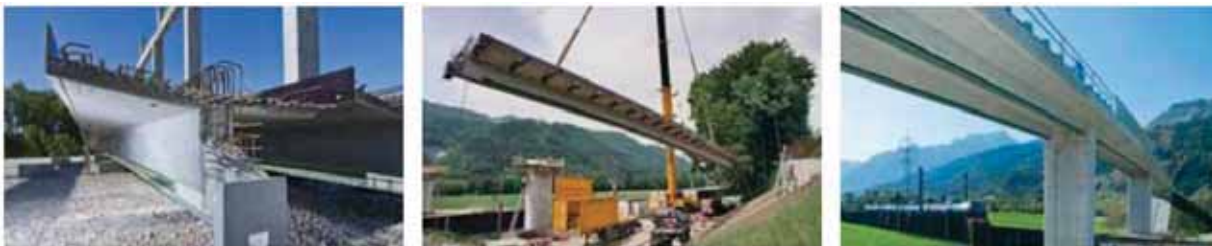
Obrázek 40: Montáž mostu ve Vigaun, Rakousko
