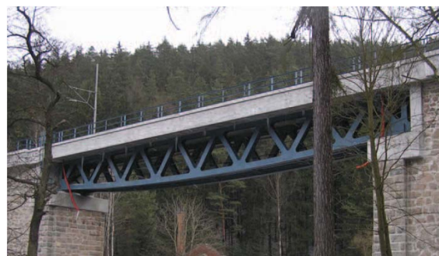
železniční most L = 35 m
