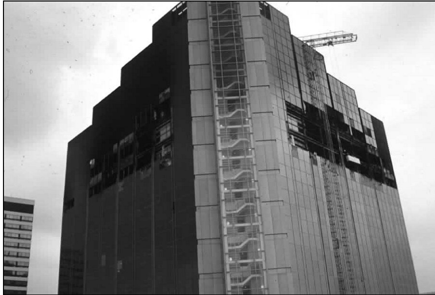
Sl. 4.3 Pogled na zgradbo Churchill Plaza, Basingstoke, po požaru
