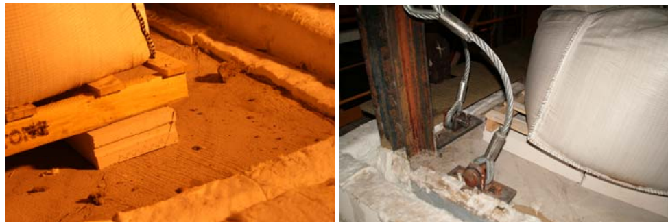
SI. 7.41 Razpokanje betona v vogalnem območju plošče
