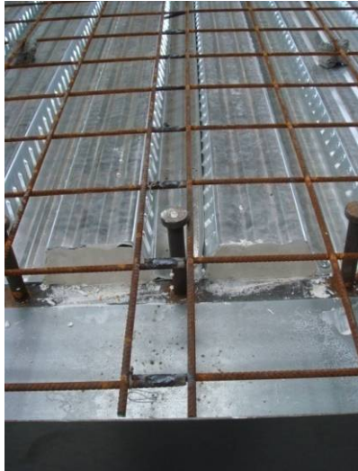
(a) Armaturne mreže so bile pred zalitjem z betonom privarjene
