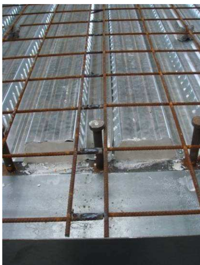
(a) Połączenie spawane przed zabetonowaniem
