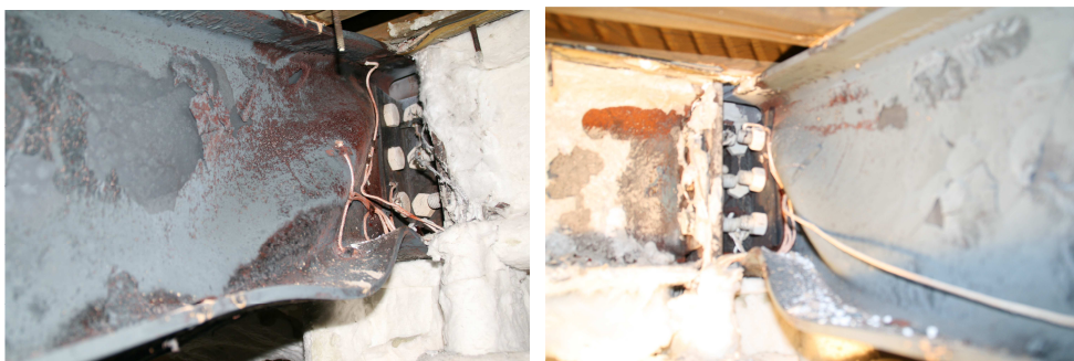
Rysunek 7.39 Lokalna utrata stateczności niezabezpieczonych belek drugorzędnych zamocowanych do słupów
