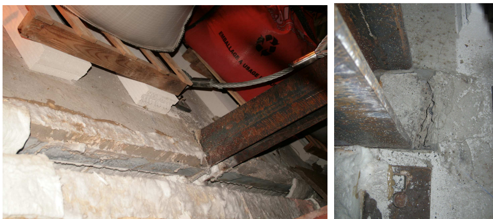
Rysunek 7.42 Pęknięcia betonu wokół słupów środkowych
