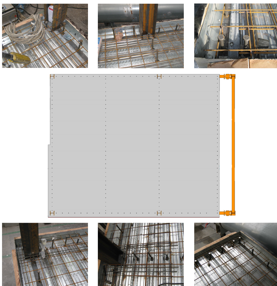
Rysunek 7.23 Różne konfiguracje stalowo-betonowych połączeń zespolonych
