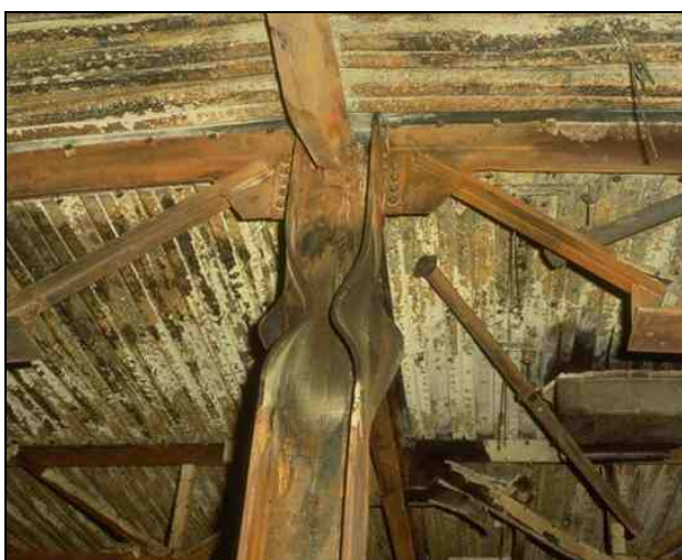
Rysunek 4.1 Wyboczony słup i zdeformowane belki w Broadgate
