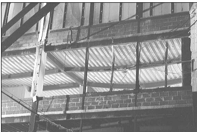
Rysunek 2.14 Zdeformowana konstrukcja podczas pożaru
