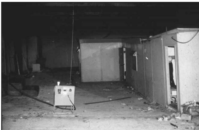
Obrázek 4.2 Pohled na deformovanou podlahu nad požárem budovy Broadgate, největší průhyb 600 mm
