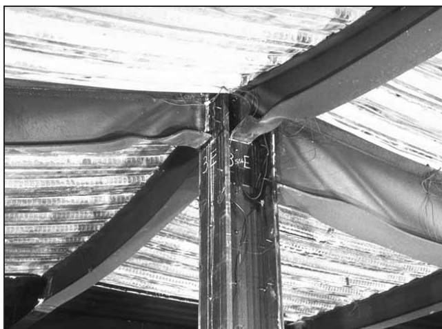
Obrázek 2.20 Boulení dolní pásnice nosníku u sloupu při zkoušce č. 6: Demonstrační zkouška
