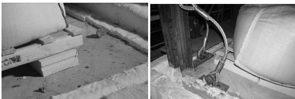
Obrázek 7.41 Trhliny betonu v rozích desky
