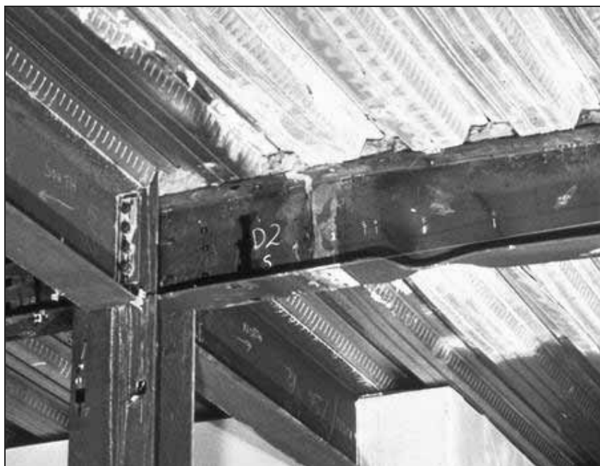
Obrázek 2.5 Boulení pásnice na nosníku v konstrukci při zkoušce č. 1: Nosník v konstrukci
