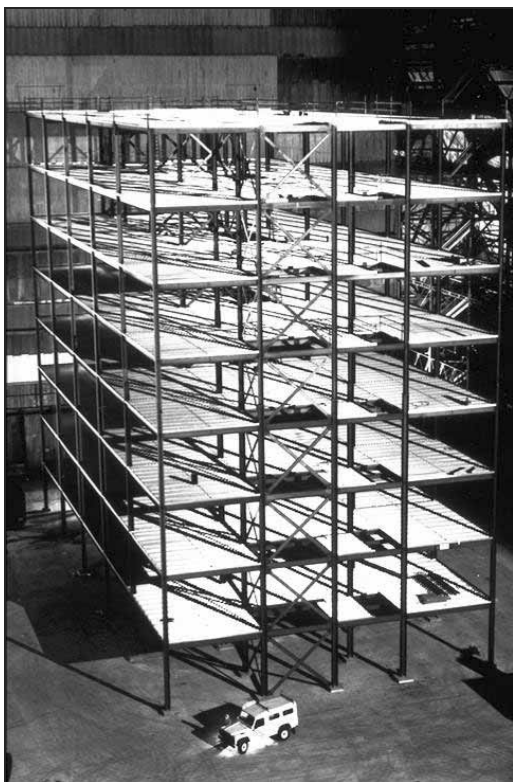
Obrázek 2.1 Zkušební budova před betonováním podlah
