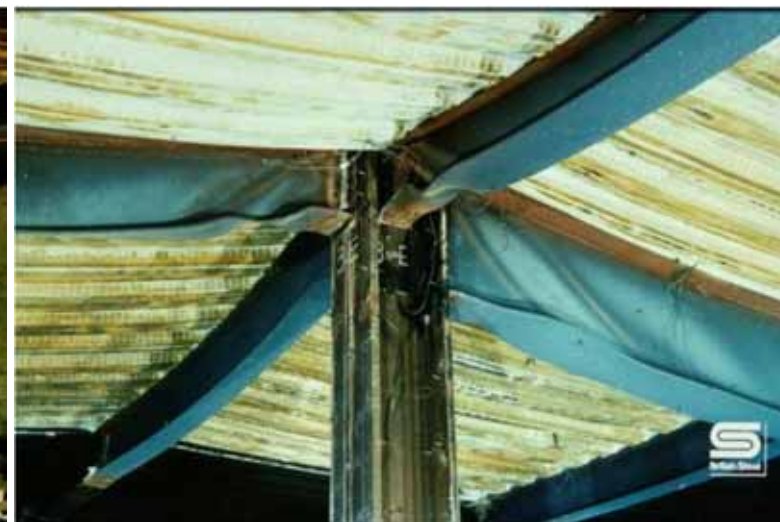
Přípoje nosníků na sloup
