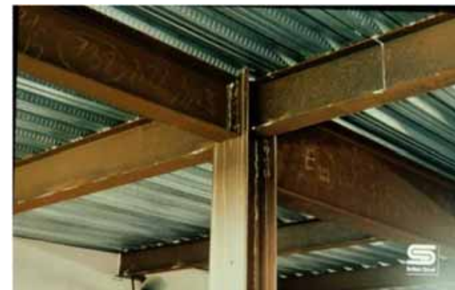
Přípoj nosníků na sloup
