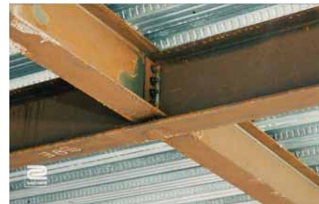
Přípoj stropnice na průvlak
