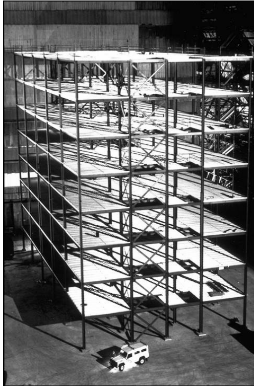
Obrázek 1-1 Zkušební budova v Cardingtonu před betonáží desek
