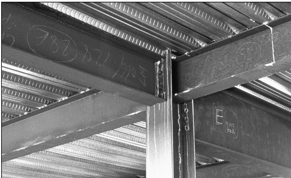
Obrázek 1-2 Pohled na požárně nechráněnou ocelovou konstrukci zkušební budovy v Cardingtonu
