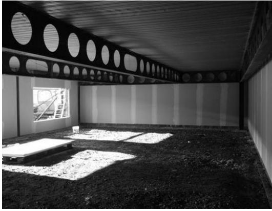
Obrázek 7.44 : Požární úsek s dlouhými nechráněnými prolamovanými nosníky
