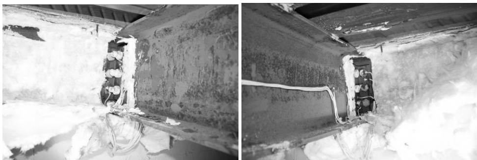
Obrázek 7.40 Stropnice připojená k průvlaku bez lokálního boulení
