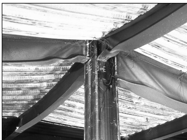
Obrázek 2.20 Boulení dolní pásnice nosníku u sloupu při zkoušce č. 6: Demonstrace zkouška
