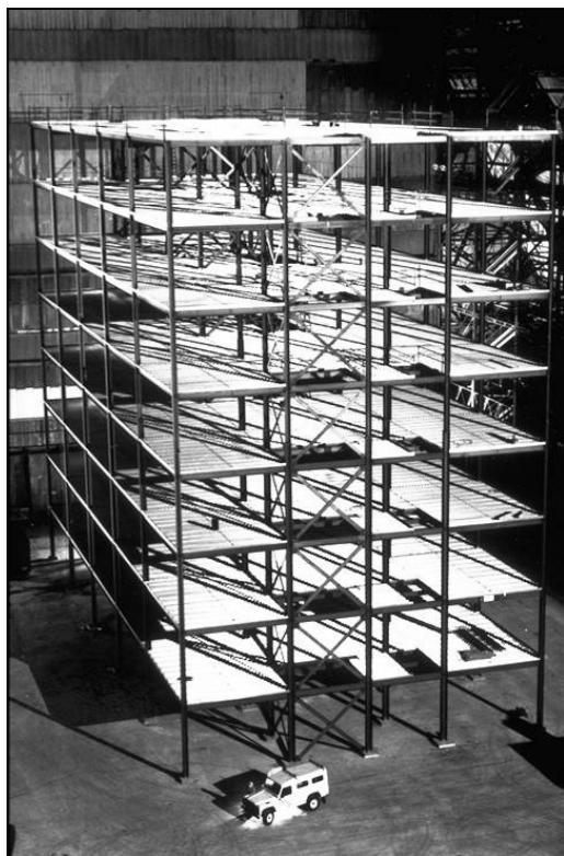
Obrázek 2.1 Zkušební budova před betonováním podlah
