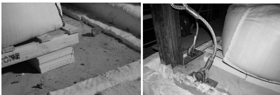
Obrázek 7.41 Trhliny betonu v rozích desky
