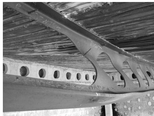
Obrázek 7.53 : Průhyb desky/nechráněného nosníku po požáru.
