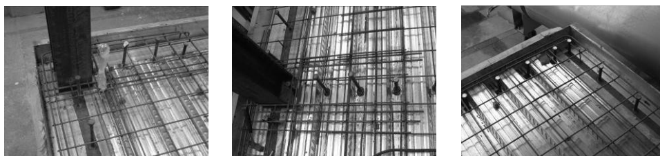
Obrázek 7.23 Uspořádání výztuže ocelobetonové desky
