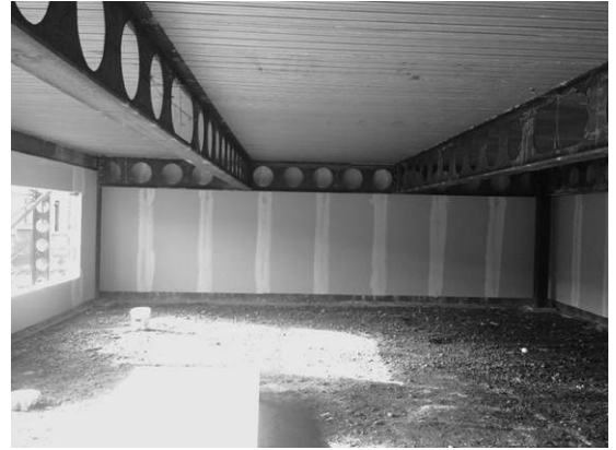
Obrázek 7.44 : Požární úsek s dlouhými nechráněnými prolamovanými nosníky
