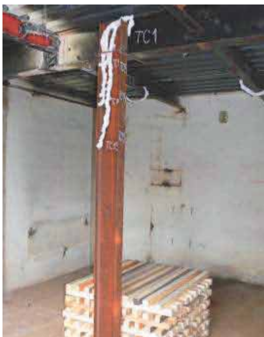
Obrázek C.27 Osazení termočlánků na sloupu
