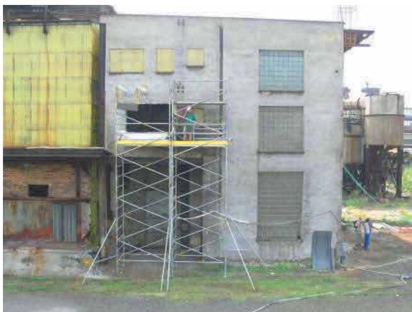
Obrázek C.21 Požární úsek ve druhém podlaží, před zkouškou
