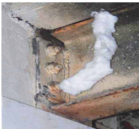
Obrázek C.24 Požárně nechráněný přípoj průvlaku ke sloupu (vlevo), Přípoj stropnice k průvlaků (vpravo)
