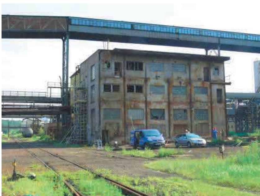
Obrázek C.20 Zkušební budova, AM Ostrava, čpavkárna, budova odstředivek
