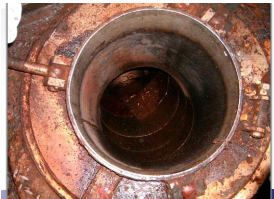
Obr. 17. Pohled do vnitřku kotle [2,3,5].
