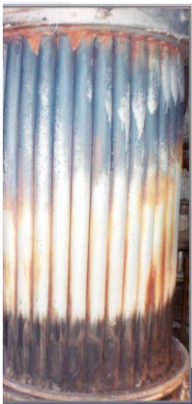
Obr. 16. Rozmístění varných trubek v kotli [2,3,5].
