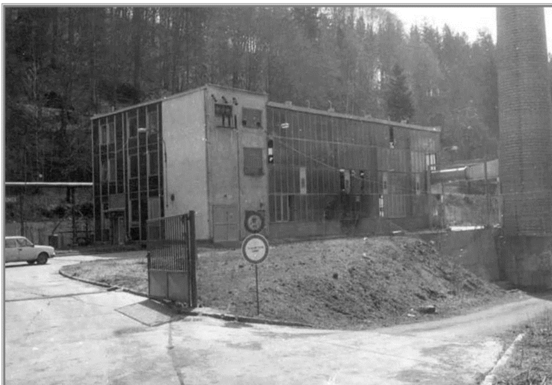
Obr. 6. Škody na budově kotelny [2,3,5].
