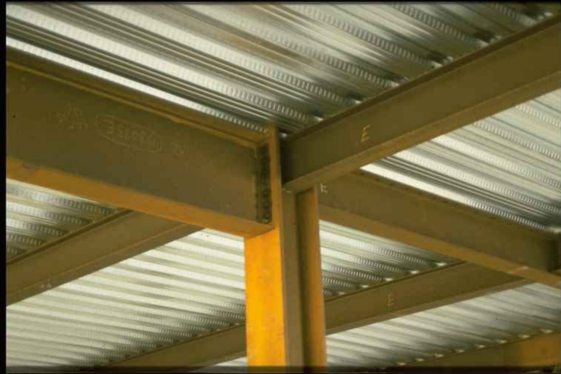
Ocelobetonová konstrukce - styčník nosník-sloup
