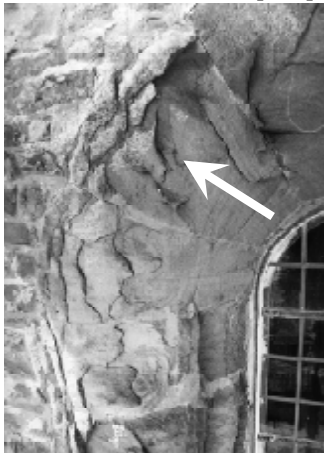
Fig. 3. Spalling
