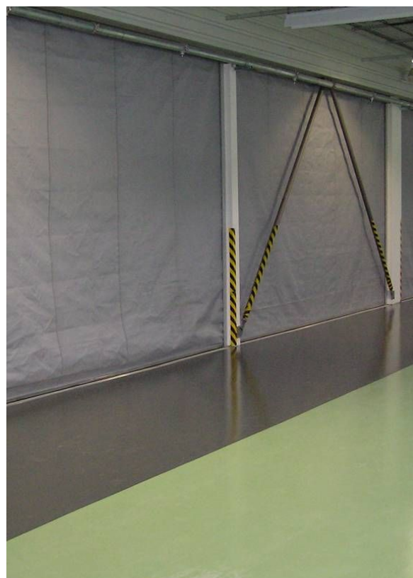
Obr. 14 – Požární roleta se zkrápěcím zařízením ( www.hasil.cz )
