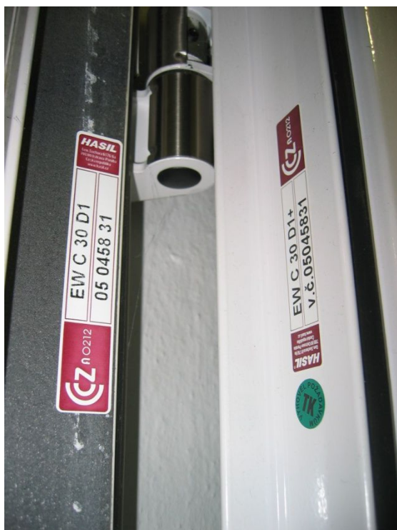
Obr. 1 - Značení požární odolnosti dveří na rámu a křídle dveří
