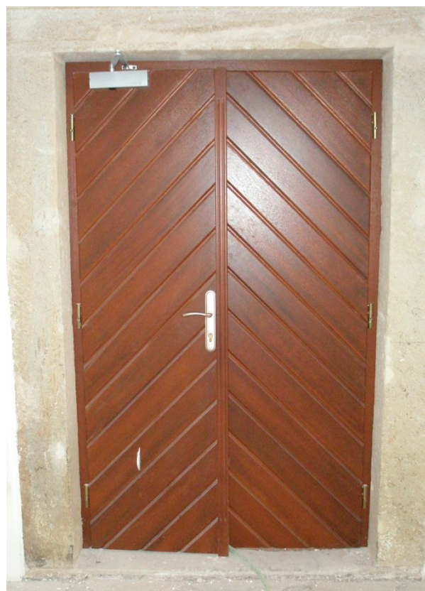
Obr. 8 – Repase dveří na Malé straně (vlození zpěňující vložky, renovace krytu křídel), položeno 22 - do pískovcové zárubně autor: Stanislav Bastl PuP, s.r.o.
