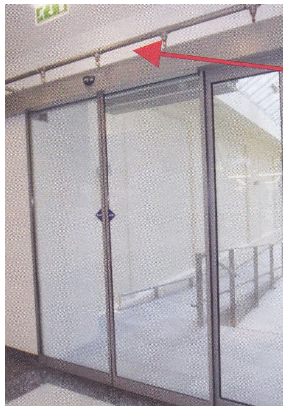
Obr. 16 – Vodní clona – na prosklený uzávěr E15 [4]
