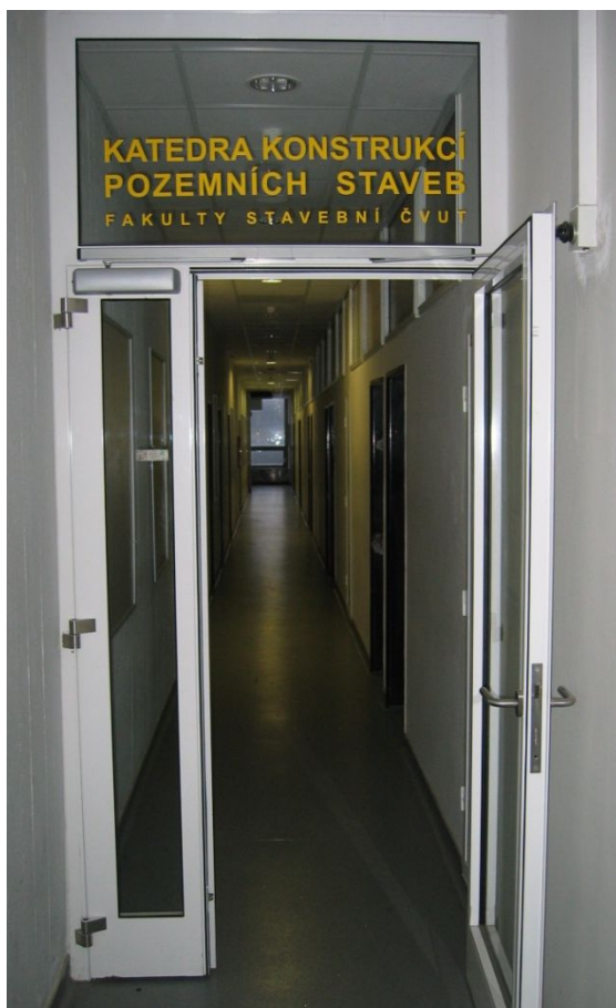
Obr. 5 – Požární dveře se samozavíračem a koordinátorem
