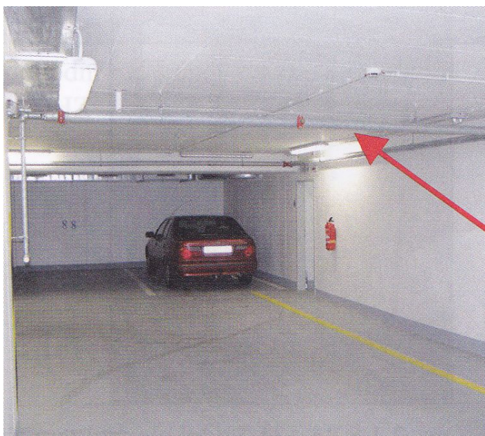
Obr. 15 – Vodní clona – rozdělení hromadných garáží [4]
