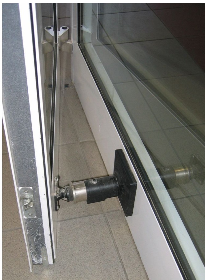
Obr. 6 – Přidržený magnet - detail
