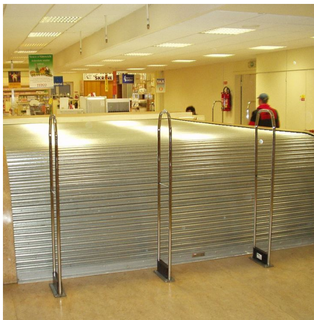
Obr. 11 – Ocelová eskalátorová požární roleta ( www.avaps.cz )
