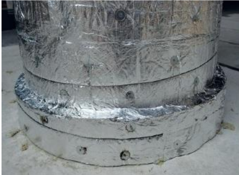
Obrázek 8: Požární ucpávka požárně dělící konstrukcí [5]
