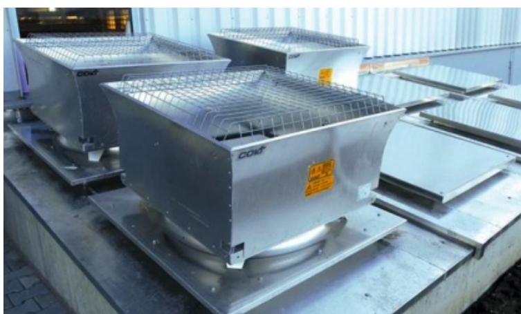
Obrázek 10: Střešní elektrický ventilátor
