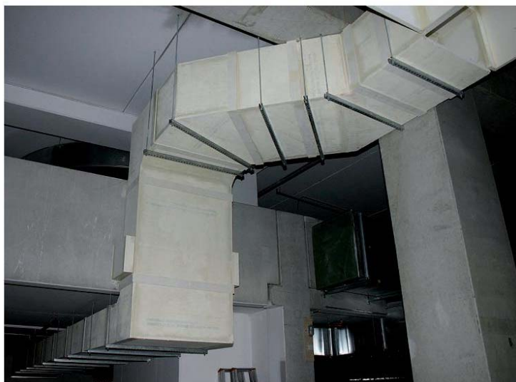
Obrázek 7: Potrubí pro odvod kouře a tepla (Promat)
