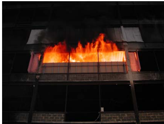
Obr. 1 Pohled na požární úsek ve 39 minutě plně rozvinutém požáru
