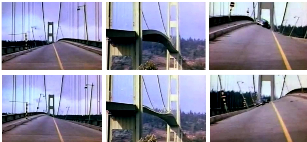
Obr. 35 Galloping mostu Tacoma Bridge, stát Washington, USA, rok 1940 (převzato z [39]).
