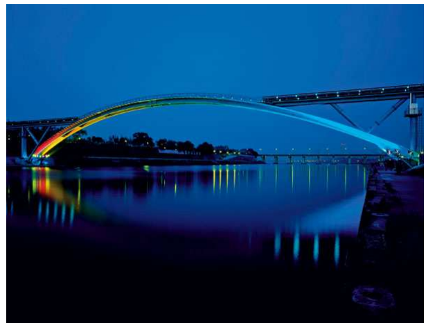
Obr. 40 Lávka pro pěší Seyonu v jihokorejském Soulu z ultravysokopevnostního betonu Ductal (převzato z [34]).
