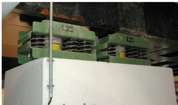
Obr. 14 Dvojice kombinovaných pružinových izolátorů s viskózními tlumiči typové řady GPVY od firmy GERB na střední podpoře základového rámu turbosoustrojí na Madeiře (převzato z [23]).
