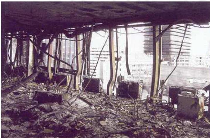
Vybočení ocelových sloupů v 9. podlaží, sloupy požárně nechráněny
