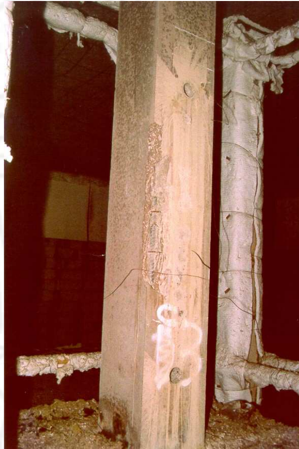
Zkouška požární odolnosti sloupu
