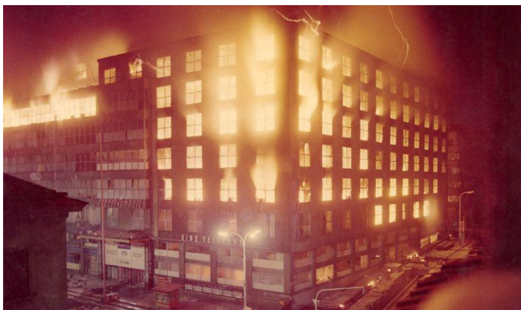
Obrázek 4: Požár Veletržního paláce [2]
