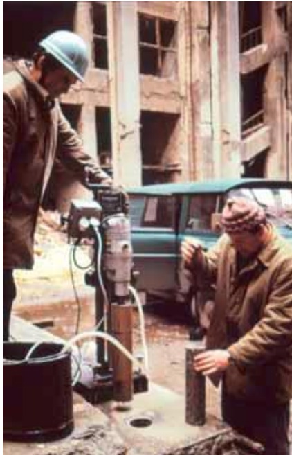
Obrázek 11: Jádrové vrtý a gama grafické prozáření prvku [3]
