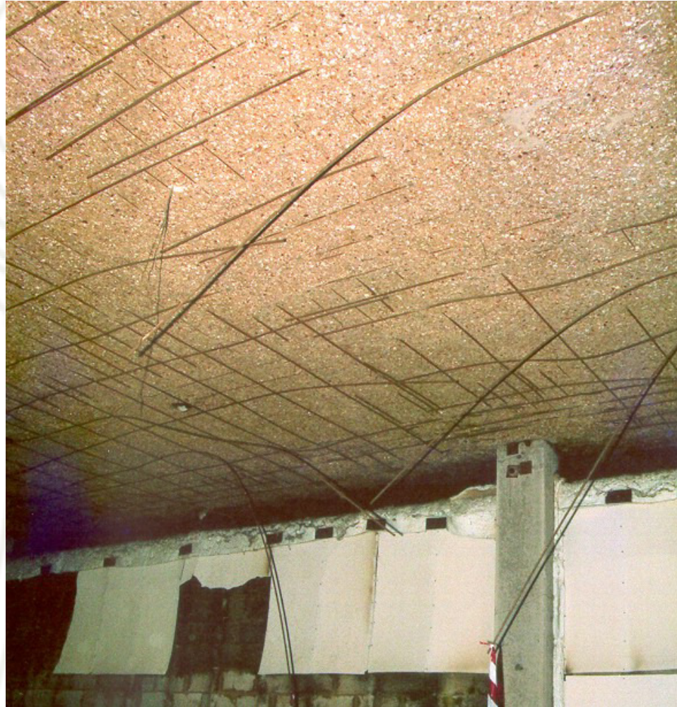
Zkouška požární odolnosti stopní desky
