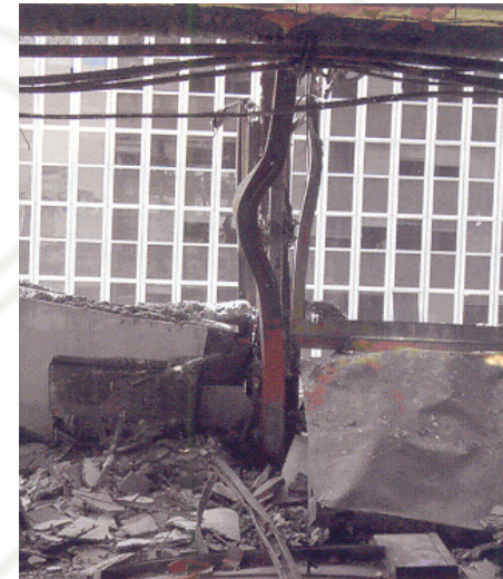
Vybočení ocelových sloupů v 9. podlaží, sloupy požárně nechráněny
