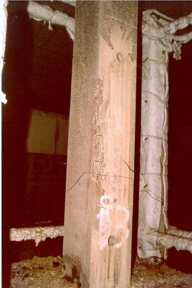
Zkouška požární odolnosti sloupu
