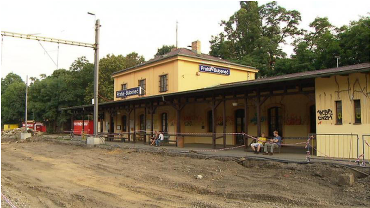
Obr. 10: Zrušená stanice Praha – Bubeneč při rekonstrukci trati v roce 2014
