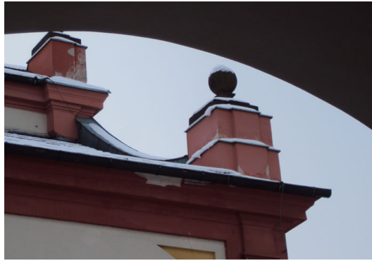
Obrázek 5.12.: Špatně viditelné napojení spodní střechy
