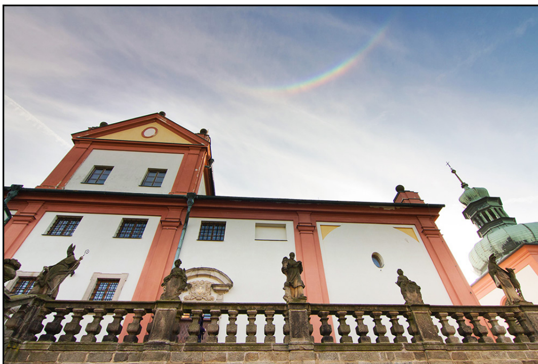
Obr. 1.3: Pohled na pravou část severní terasy
