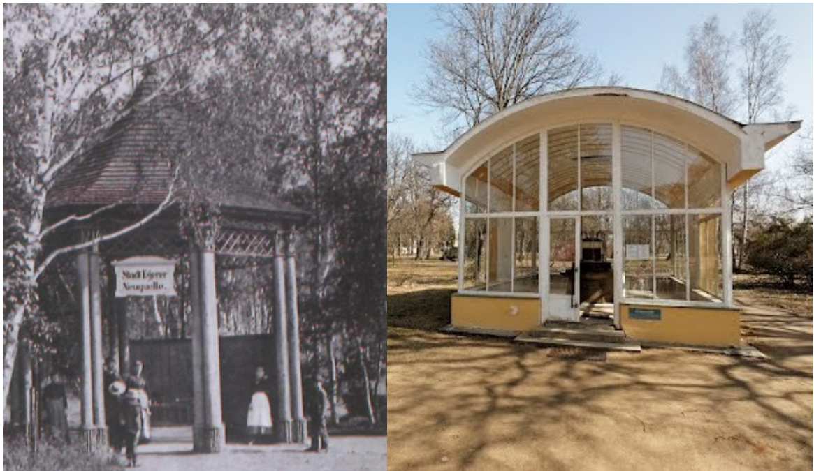
Obrázek 11 – Nový pramen – porovnání původní a současné stavby [6]
