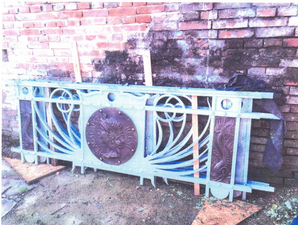
Obr. 10 Aplikace celého systému protikorozní ochrany segmentu zábradlí Čechova mostu
