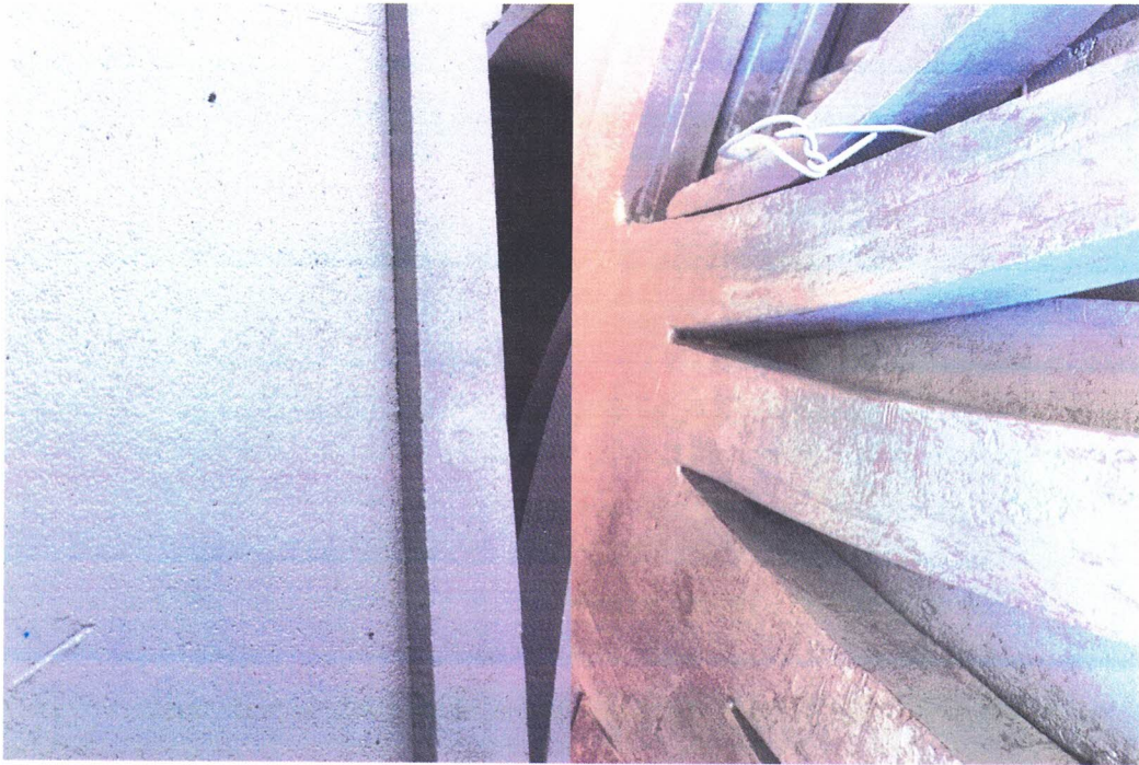
Obr. 7 Předúprava povrchu tryskáním před aplikaci žárového zinku ponorem – čistota povrchu Sa 3
