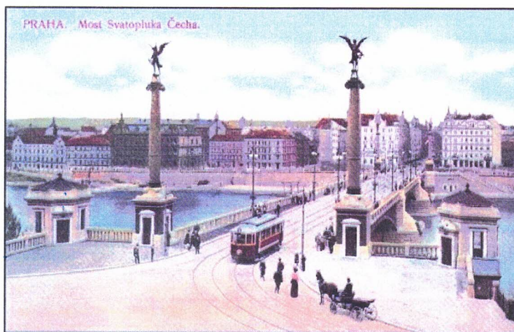
Obr. 1 Historická fotografie Čechova mostu
