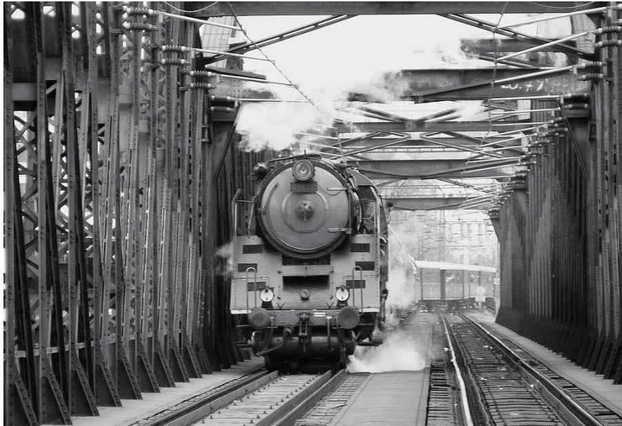
Obr. 1 Železniční most pod Vyšehradem
