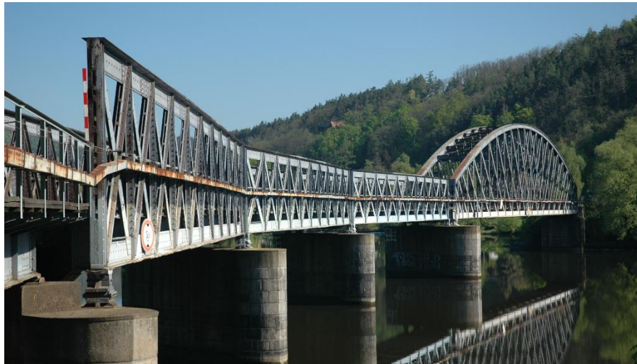
Obr. 4 Most ve Skochovicích
