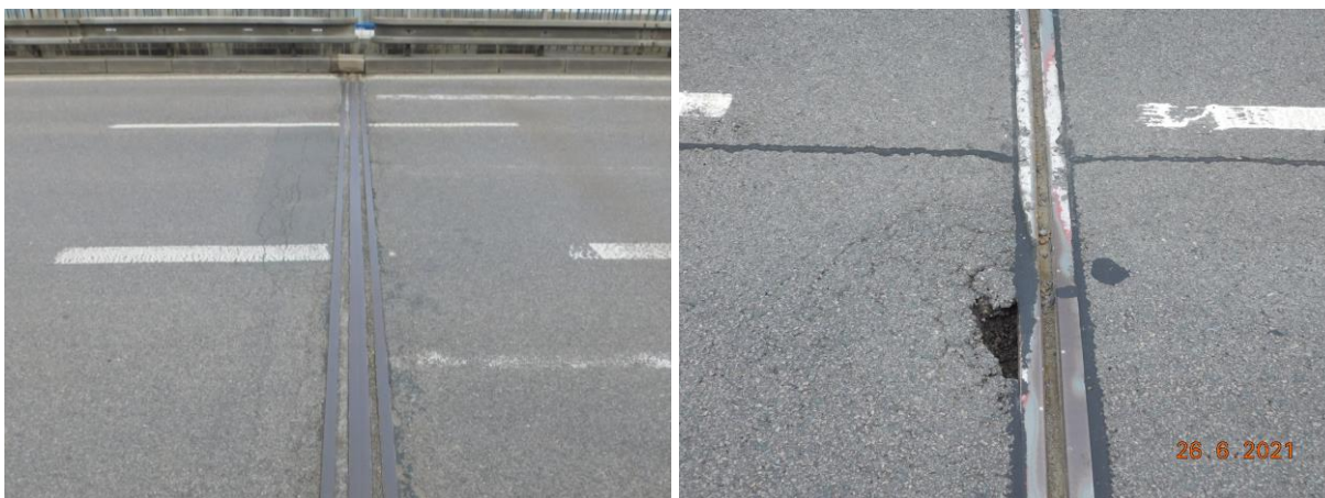
Obrázek 28: Vlevo přechodová oblast zvlněna, viditelné příčné nebo podélné nerovnosti, vpravo u přechodové oblasti výtluky různého rozsahu
