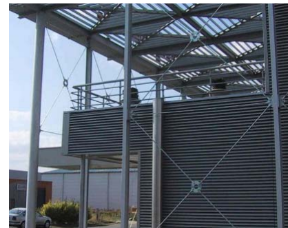
OK01 – Ocelové konstrukce (8)
