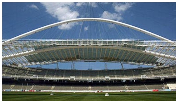
OK01 – Ocelové konstrukce (10)
