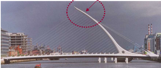
Beckettův most v Dublinu (arch S. Calatrava)
