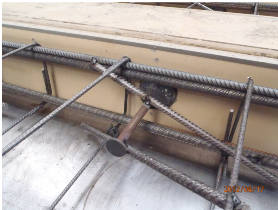
Obr. 20 Ukázka osazení "Trn s kulovou hlavou"
