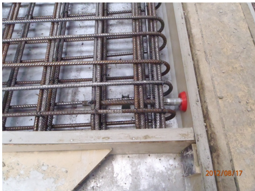
Obr. 18 Ukázka uložení manipulačního trnu
