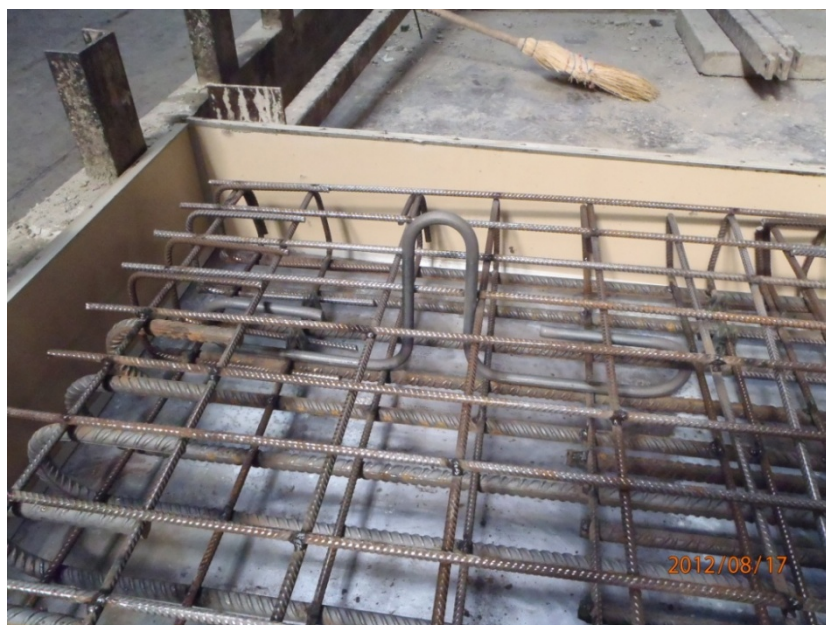
Obr. 19 Ukázka osazení klasického úchytu
