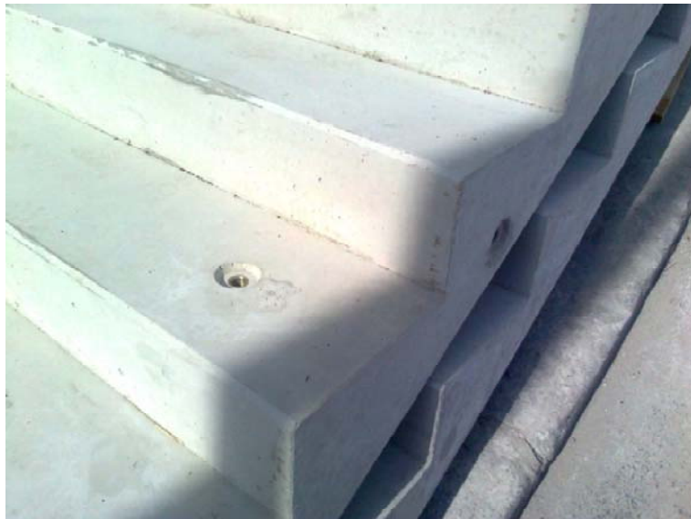
Obr. 22 Finální podoba úchytu se závitovým pouzdrém
