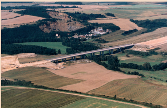
stavba mostu na dálničním obchvatu Plzně
