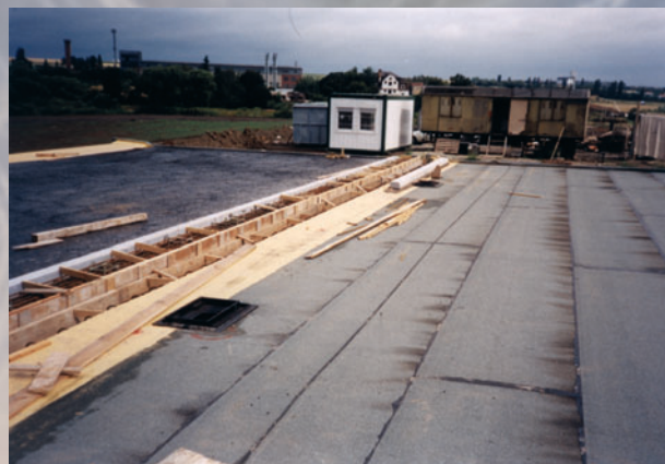
stavba mostů na dálničním okruhu okolo Prahy
