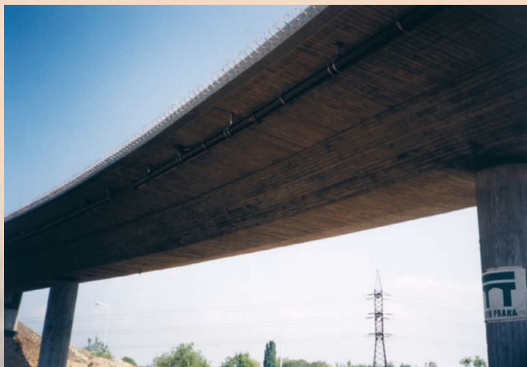
stavba mostů na dálničním okruhu okolo Prahy
