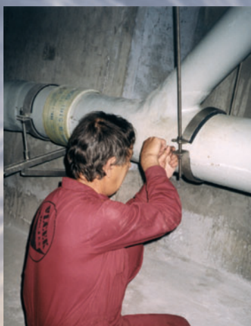
montáž mostního odvodnění
