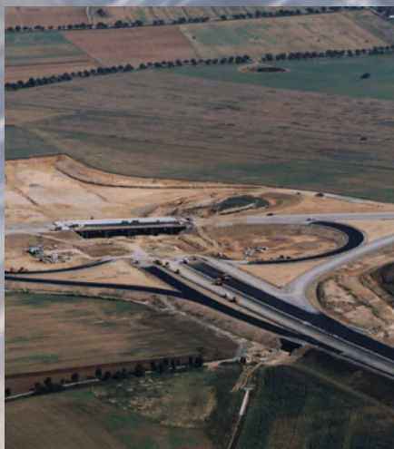
stavba dálničního obchvatu Plzeň
