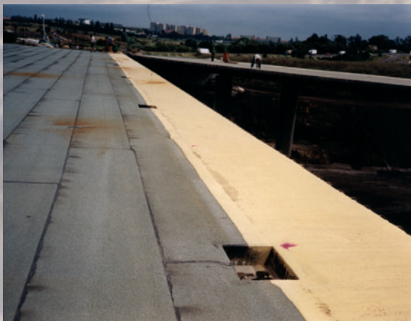
stavba mostů na dálničním okruhu okolo Prahy
