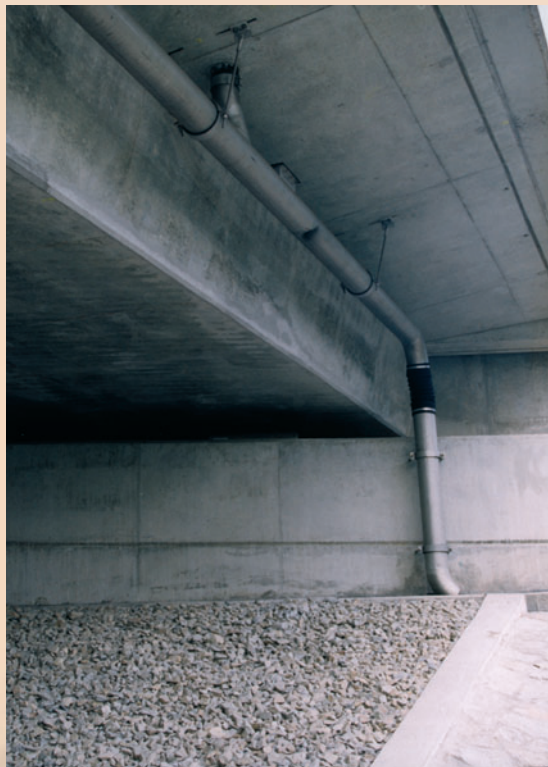
vyústění mostního odvodnění
