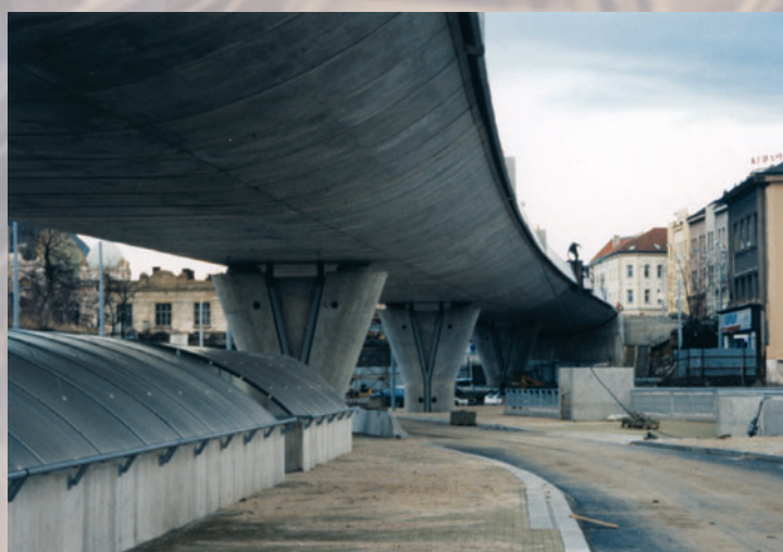
stavba „Estakáda U trati“ v Plzni
