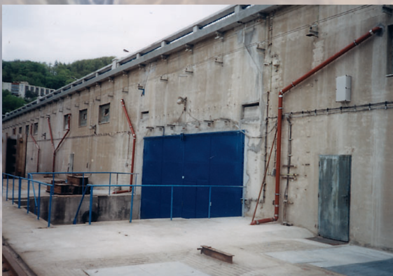
odvodnění hráze Orlické přehrady
