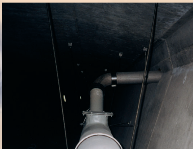
napojení příčného svodu do podélného
