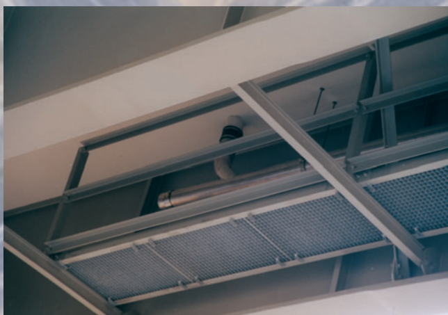
napojení odvodňovače na podélný svod
