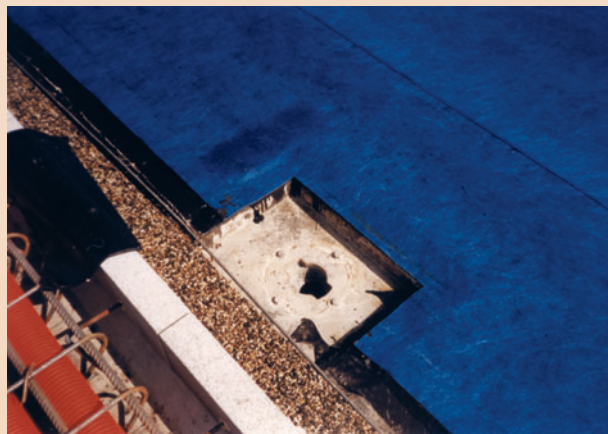
napojení izolace na talíř odvodňovače
