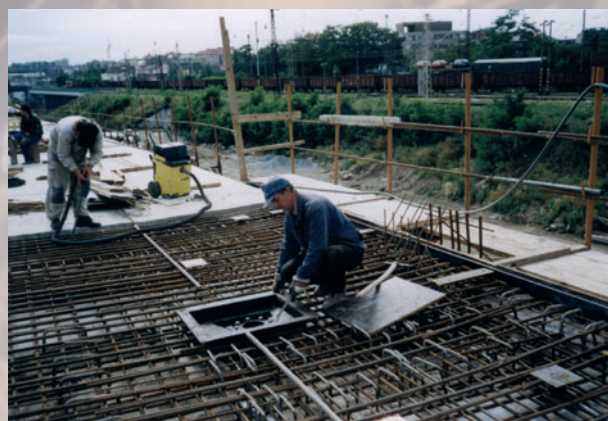
osazení talíře odvodňovače
