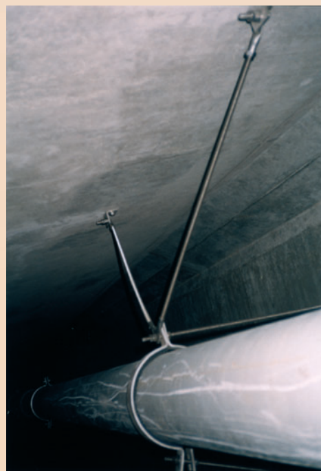
zavěšení podélného svodu
