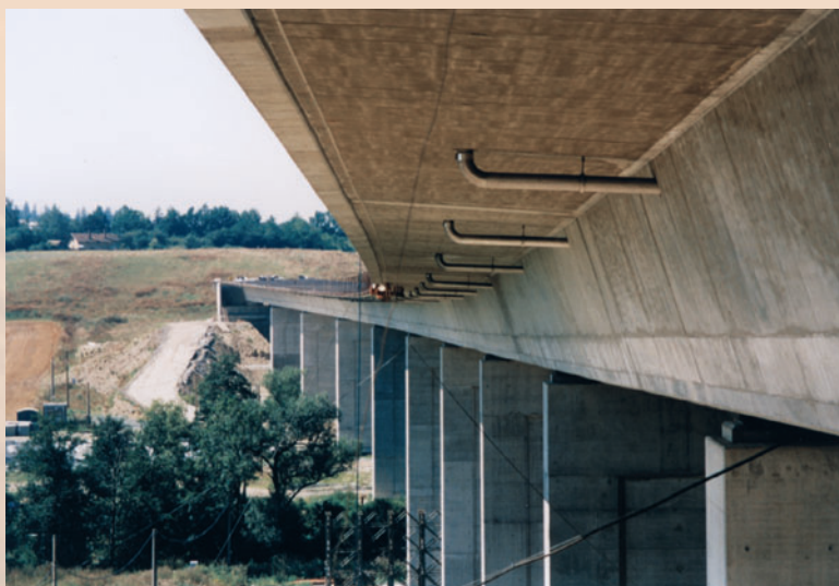
stavba dálničního mostu na obchvatu Plzně
