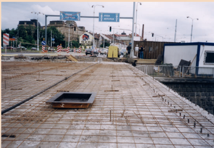
rekonstrukce mostu „U Jána“ v Plzni
