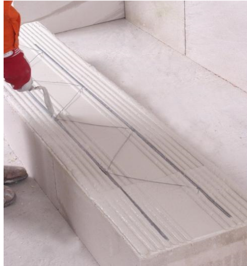
Obr. 8 Výztuž MURFOR ® v ložné spáře zdiva brání vzniku trhlin a zvyšuje únosnost prvku v ohybu.
