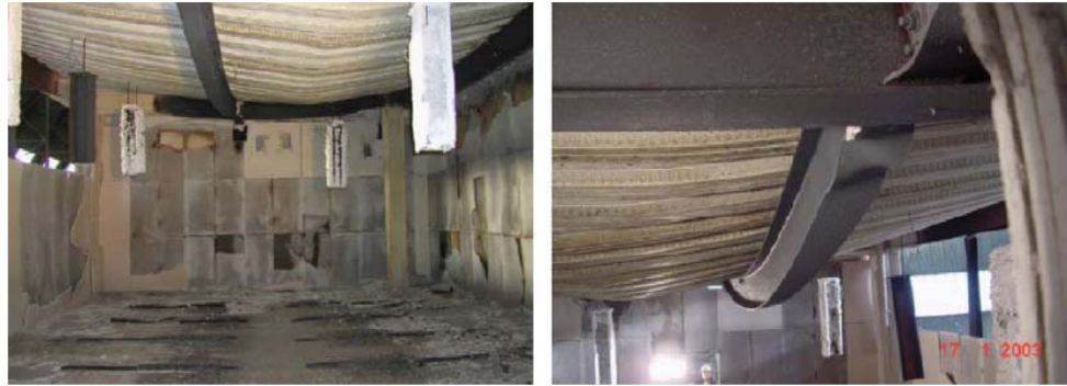
Figura 2.25 Vista del forjado después del ensayo
