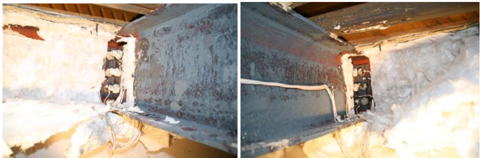
Figura 7.40 Sin pandeo local de las vigas secundarias sin protección conectadas a las vigas principales
