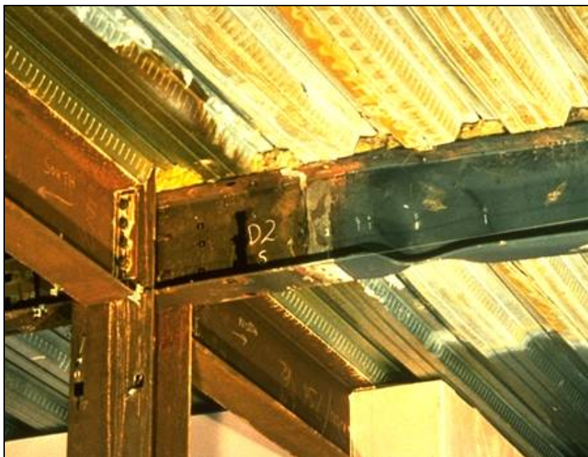
Figura 2.5 Pandeo del ala en la viga arriostrada
