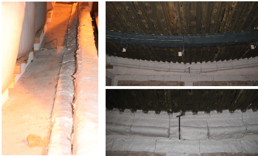
Figura 7.37 Colapso de viga de extremo
