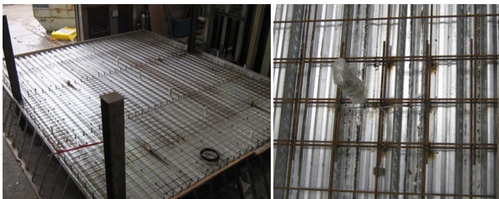
Figura 7.43 Superposición del mallazo de acero de armadura en losa colaborante
