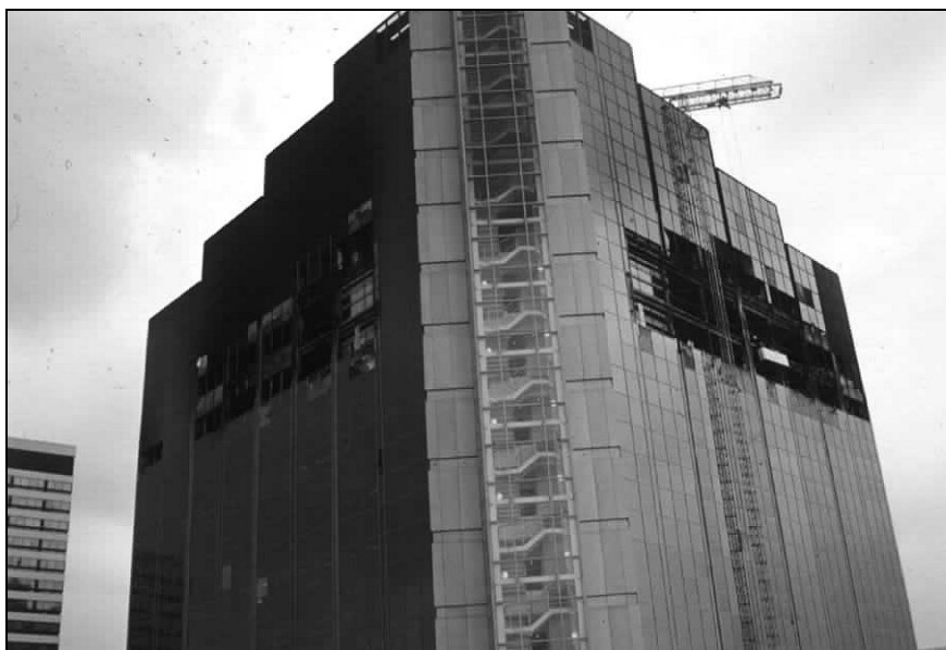
Figura 4.3 Churchill Plaza, Basingstoke, tras el incendio
