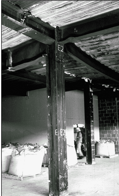
Figura 2.10 Vista del siguiente ensayo estructural
