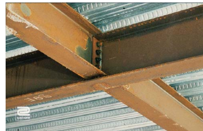
Unión viga con viga
