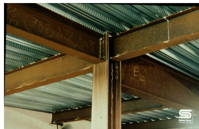
Unión viga con columna
