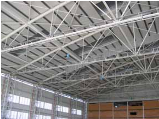
Otvory pro kouřovou a požární ventilaci
