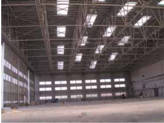
Vnitřní prostor hangáru s příhradovou konstrukcí
