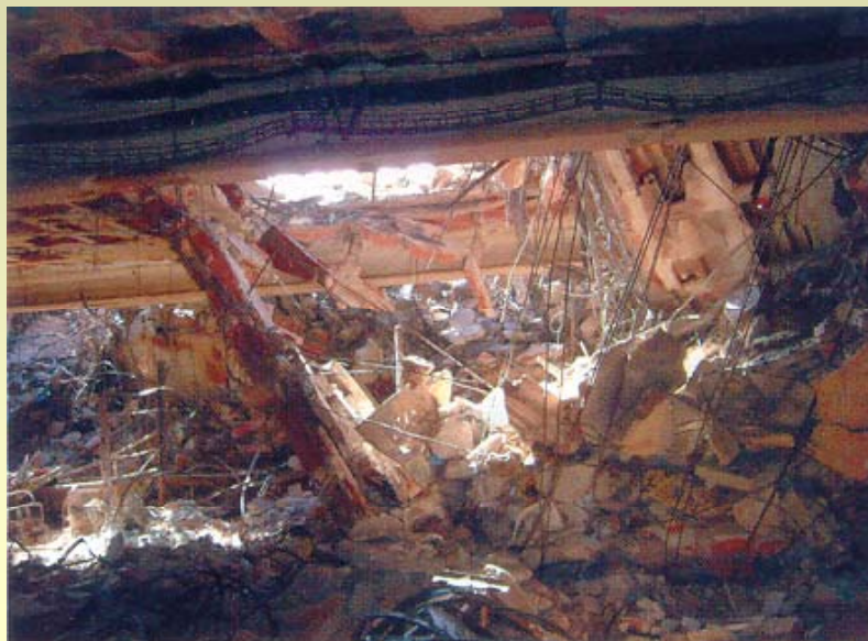
Suť propadlá z 18. podl. na 17. podl.
