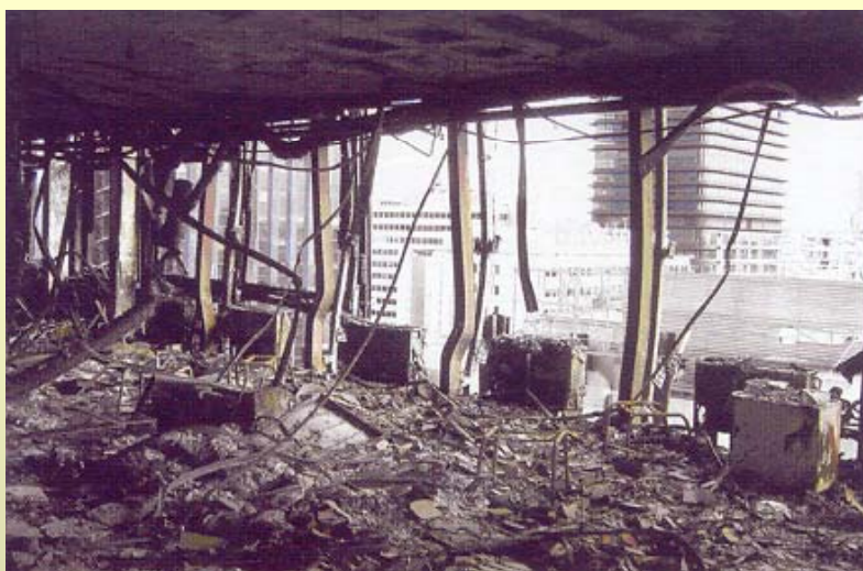
Vybočení ocelových sloupů pláště v 9. podlaží
