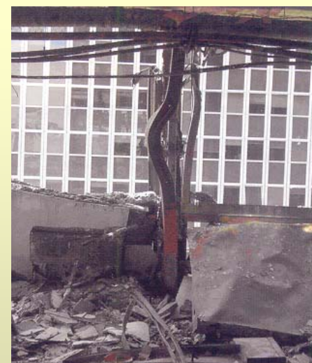
Vybočení ocelových sloupů pláště v 9. podlaží
